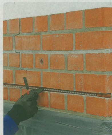
115 Jak naprawiać uszkodzone mury
