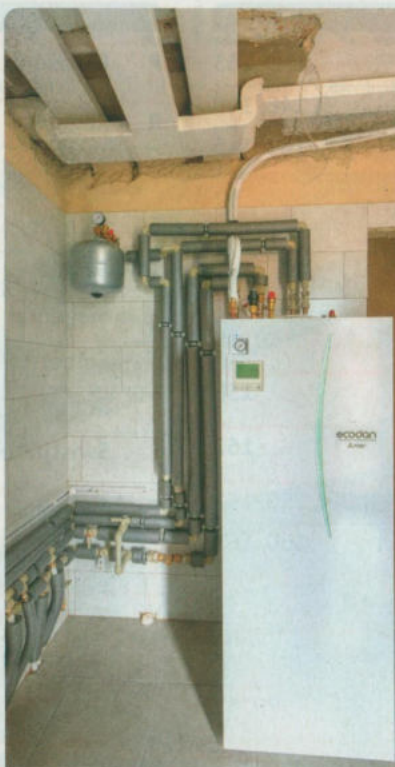
118 Montaż powietrznej pompy ciepła
