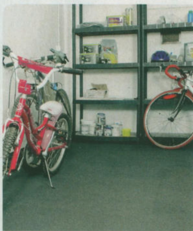
90 Posadzka epoksydowa w garażu
