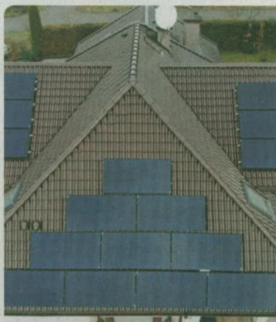
106 Montaż paneli fotowoltaicznych
