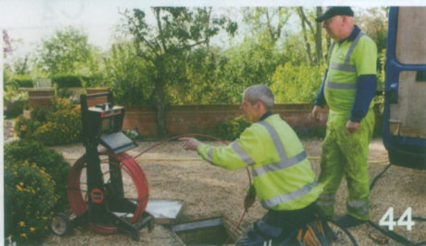
Czyszczenie sieci kanalizacji zbiorczej
