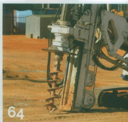
Technologie bezwykopowe w systemach kanalizacyjnych
